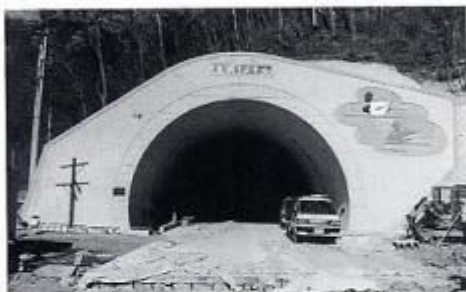
開通近い生坂トンネル(平成元年9月貫通) 延長1,129m 幅10.9m 高さ7.7m
