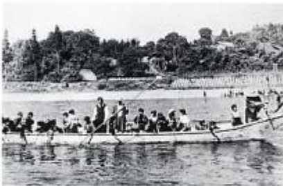
日岐の渡し (昭和7年ごろ) 昭和8年に八丁橋が架かり廃止
