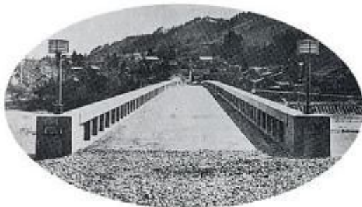
昭和6年の陸橋
