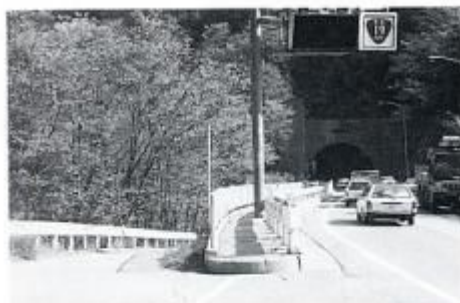
池沢トンネル(昭和50年開通) 延長377m 幅9.5m 高さ4.5m
